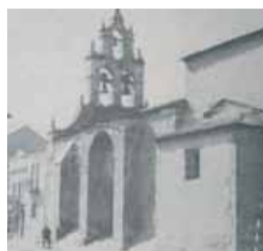
Ancienne église Saint-Pierre démolie au vingtième siècle où l'on conservait le tableau du miracle – Ponferrada
